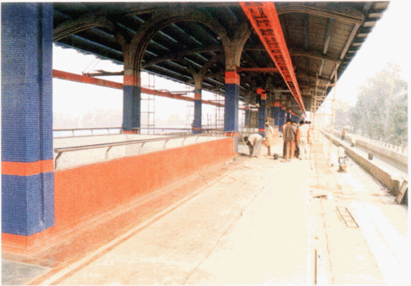
सीलमपुर स्टेशन - मेट्रो रेल (निर्माणधीन) Work under Progress at Seelampur Station, Metro Rail
