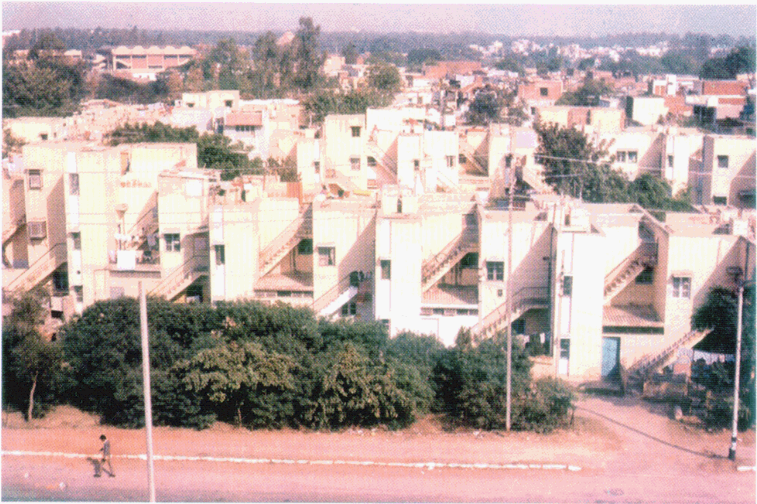
कटवारिया सराय में डी.डी.ए. मकानों का निर्माण Housing by DDA at Katwaria Sarai
