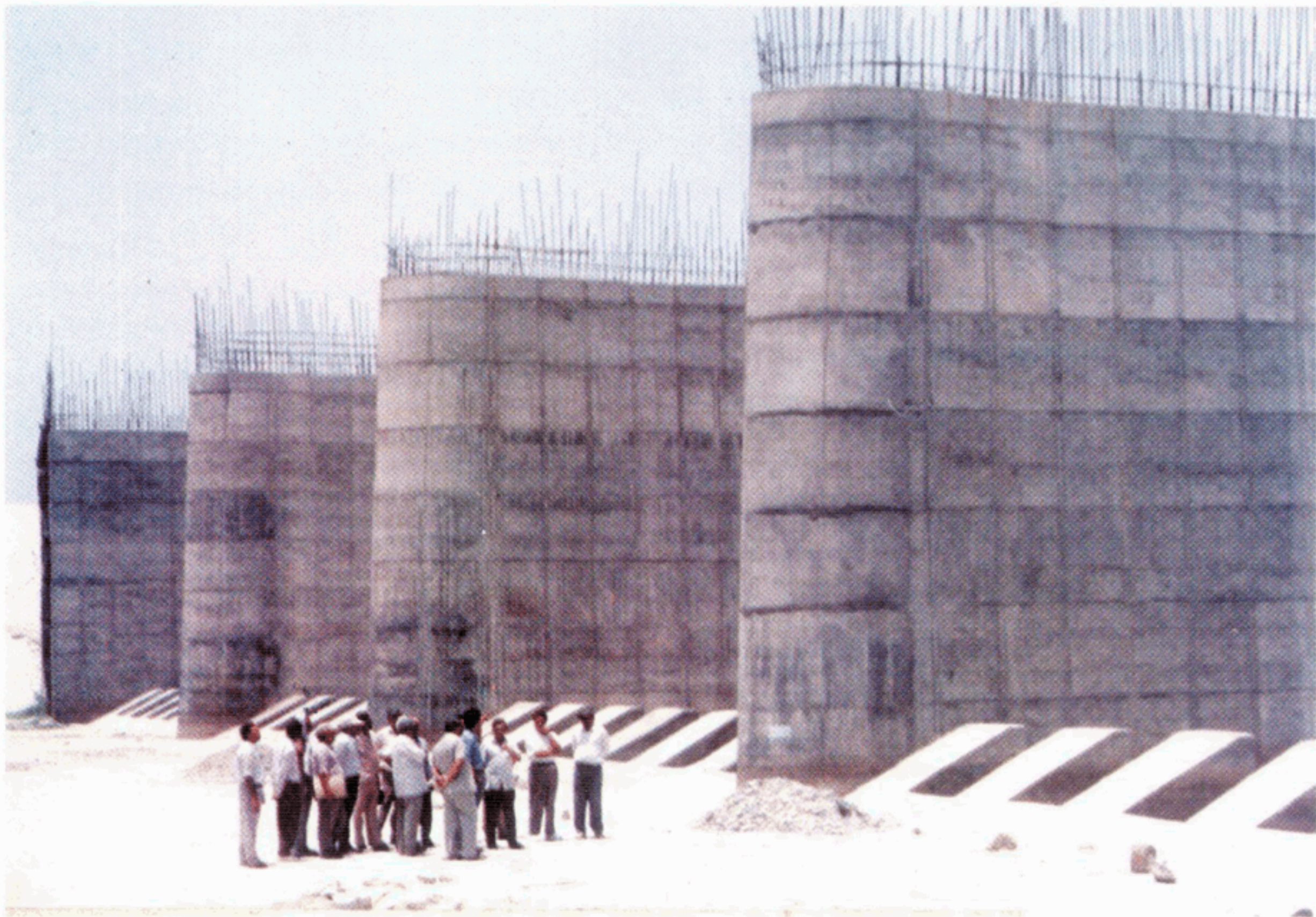
कानपुर में गंगा बैराज का निर्माण Ganga Barrage Construction at Kanpur in progress
