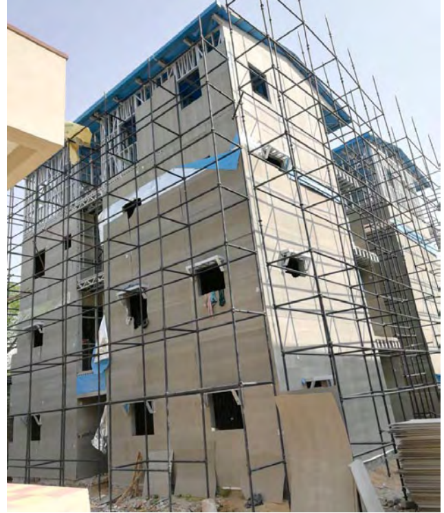
गाचीबाउली, हैदराबाद, तेलंगाना में बीएमटीपीसी के द्वारा कॉफर स्ट्रक्चरल स्टे इन प्लेस फ्रेमवर्क प्रणाली (16 मकान) एवं लाइट गॉज स्टील फ्रेमवर्क प्रणाली (16 मकान) का उपयोग करते निर्माणाधीन प्रदर्शन आवास।
