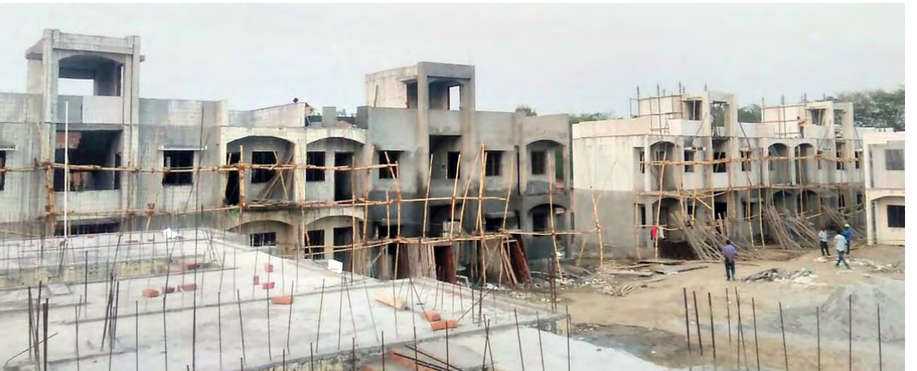
औरंगाबाद जागिर, लखनऊ, उत्तर प्रदेश में बीएमटीपीसी के द्वारा स्टे इन प्लेस ईपीएस बेस्ड डबल वाल पैनेल प्रणाली के उपयोग द्वारा निर्माणाधीन प्रदर्शन आवास।
