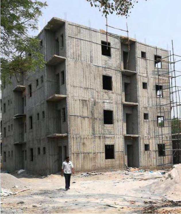
गाचीबाउली, हैदराबाद, तेलंगाना में बीएमटीपीसी के द्वारा कॉफर स्ट्रक्चरल स्टे इन प्लेस फ्रेमवर्क प्रणाली (16 मकान) एवं लाइट गॉज स्टील फ्रेमवर्क प्रणाली (16 मकान) का उपयोग करते निर्माणाधीन प्रदर्शन आवास।
