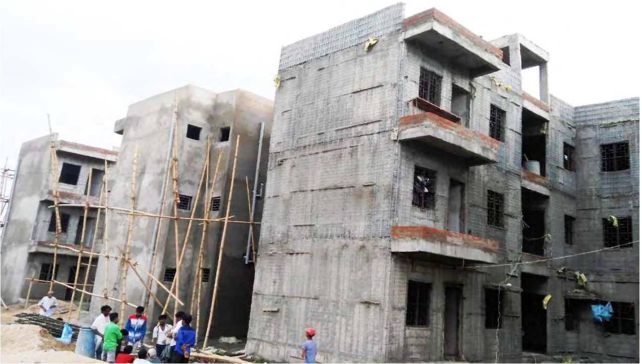
बिहारशरीफ, बिहार में बीएमटीपीसी के द्वारा कॉफर स्ट्रक्चरल स्टे इन प्लेस फ्रेमवर्क प्रणाली का उपयोग करते हुए निर्माणाधीन प्रदर्शन आवास।
