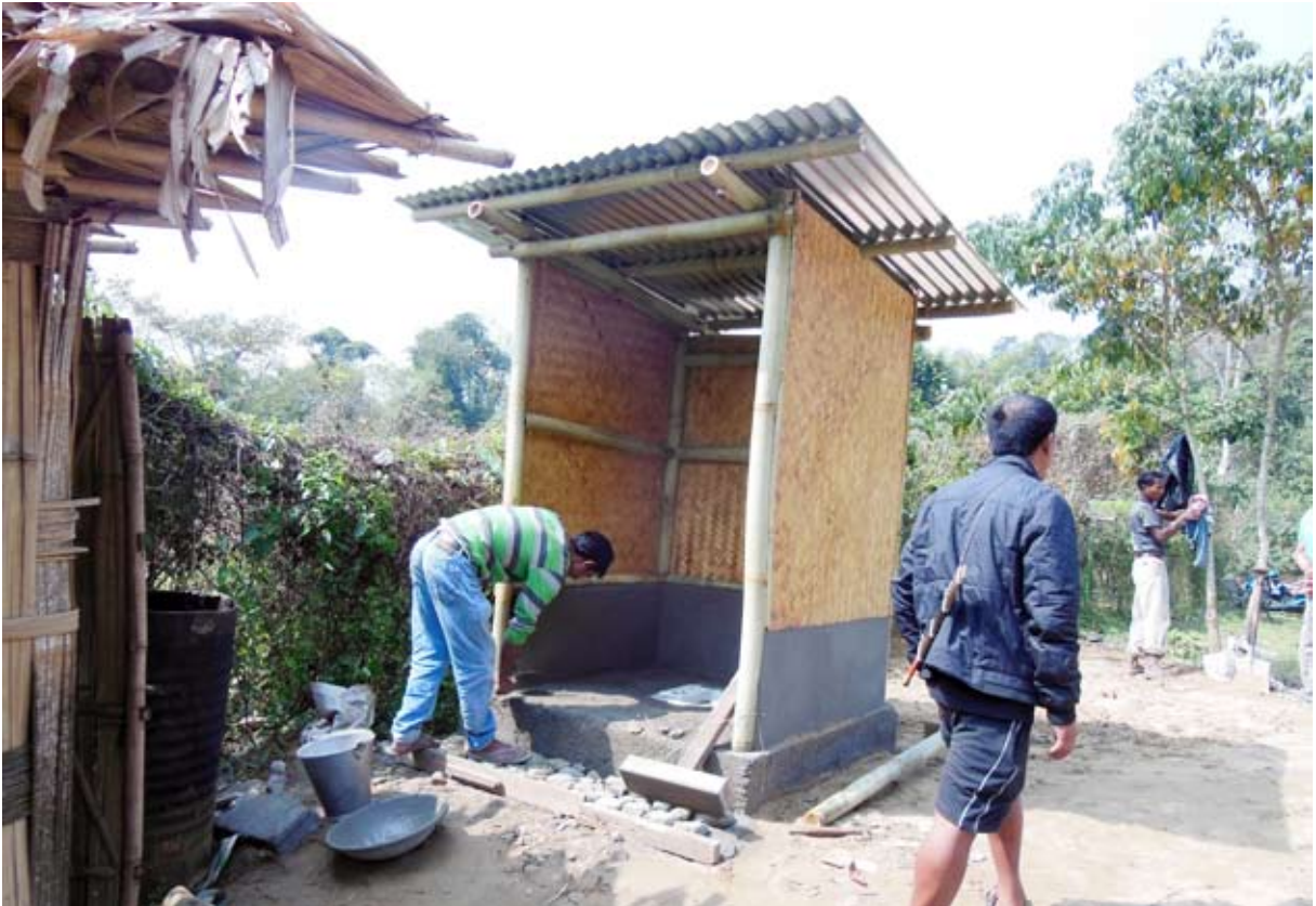
29 फरवरी से 5 मार्च, 2016 के दौरान ईटानगर, अरुणाचल प्रदेश में आवास एवं भवन निर्माण में बांस के उपयोग पर प्रशिक्षण कार्यक्रम के दौरान बांस शौचालय का निर्माण
