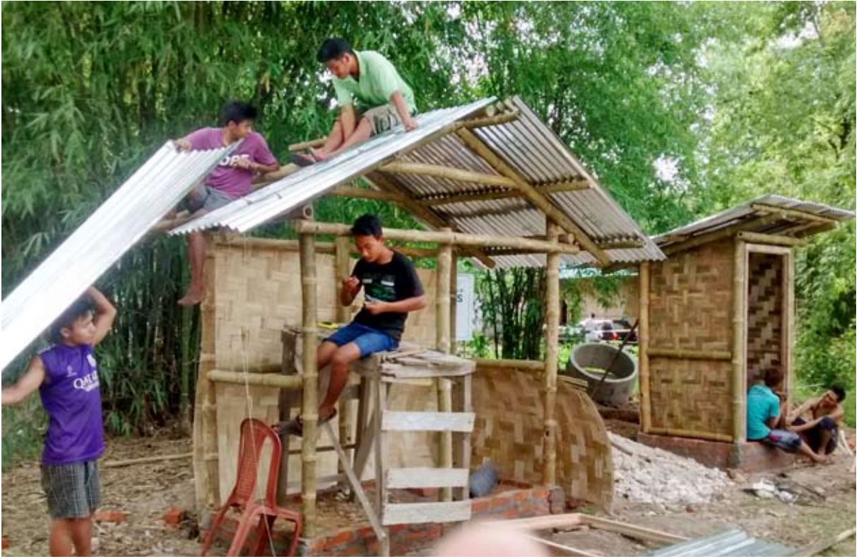
12-16 मई, 2015 को दीमापुर, नागलैंड में बीएमटीपीसी द्वारा आयोजित आवास एवं निर्माण की बांस संरचना पर प्रशिक्षण कार्यक्रम के दौरान बांस शौचालय का निर्माण
