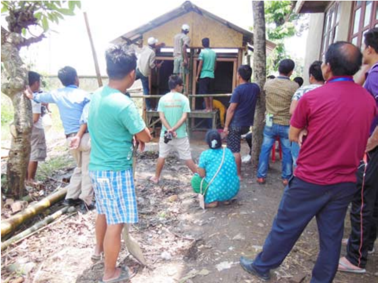
13-17 मई, 2016 को इम्फाल, मणिपुर में “बांस आधारित शौचालय निर्माण” पर प्रशिक्षण कार्यक्रम के दौरान शौचालय का निर्माण
